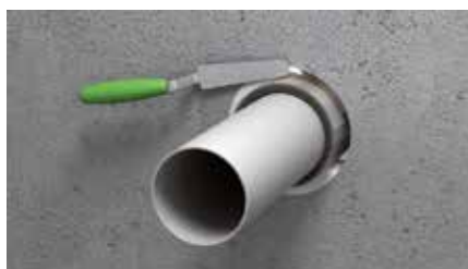
5. Заповнити отвір спеціальною піною чи будівельним розчином
